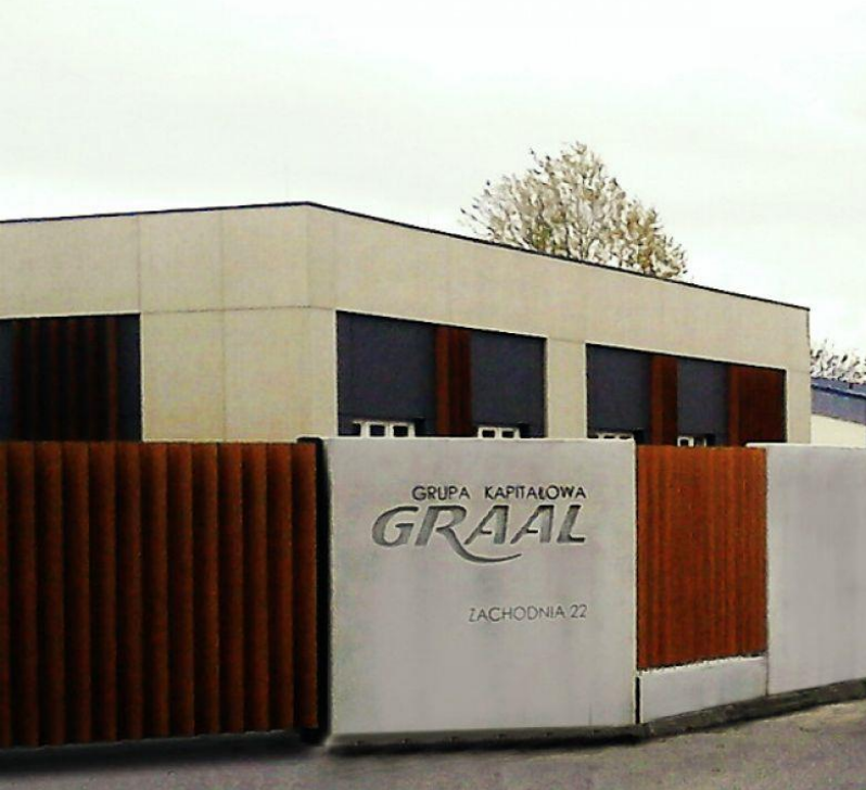
OGRODZENIE Z PREFABRYKLATÓW PŁASKICH UKŁADANYCH W FUNDAMENT KIELICHOWY Z TŁOCZONYM LOGIEM – WEJHEROWO – INWESTOR GK GRAAL
