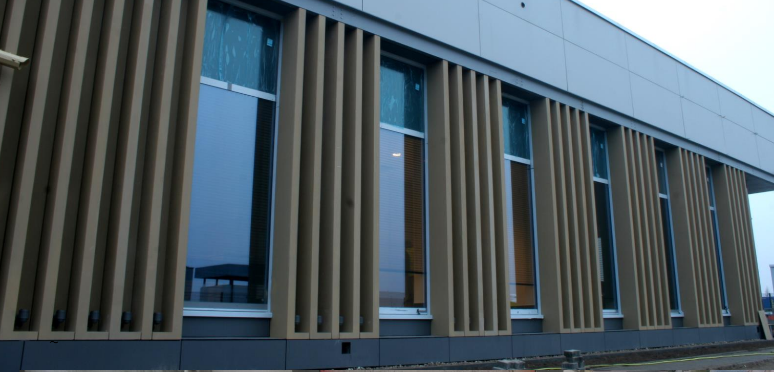
BUDYNEK BIUROWY W BŁONIU – ŻYŁKI I PLYTY OKŁADZINOWE 30mm W KOLORZE BEŻOWYM, BARWIONE W MASIE
