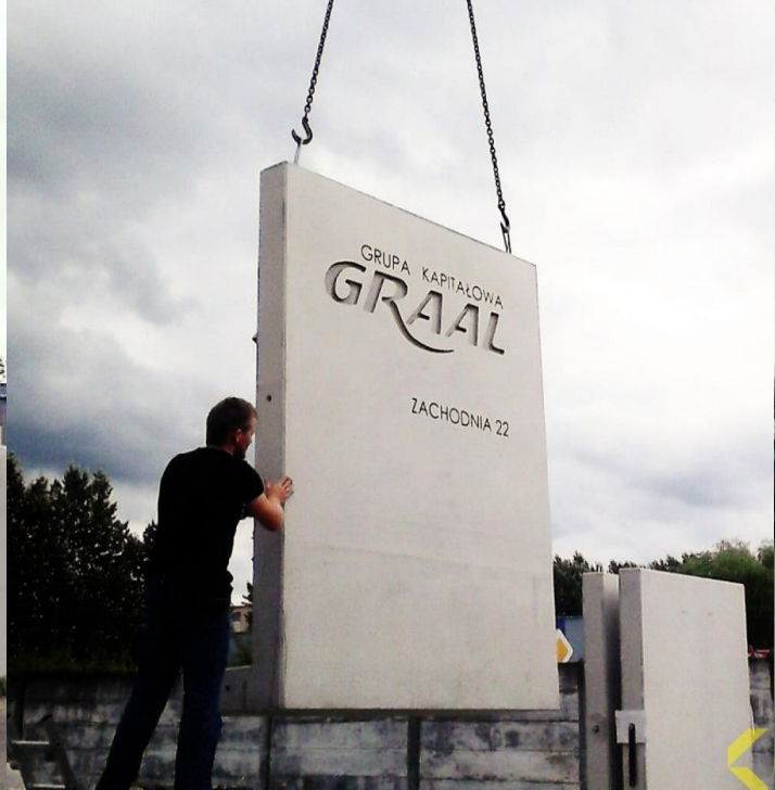
OGRODZENIE Z PREFABRYKLATÓW PŁASKICH UKŁADANYCH W FUNDAMENT KIELICHOWY Z TŁOCZONYM LOGIEM – WEJHEROWO – INWESTOR GK GRAAL
