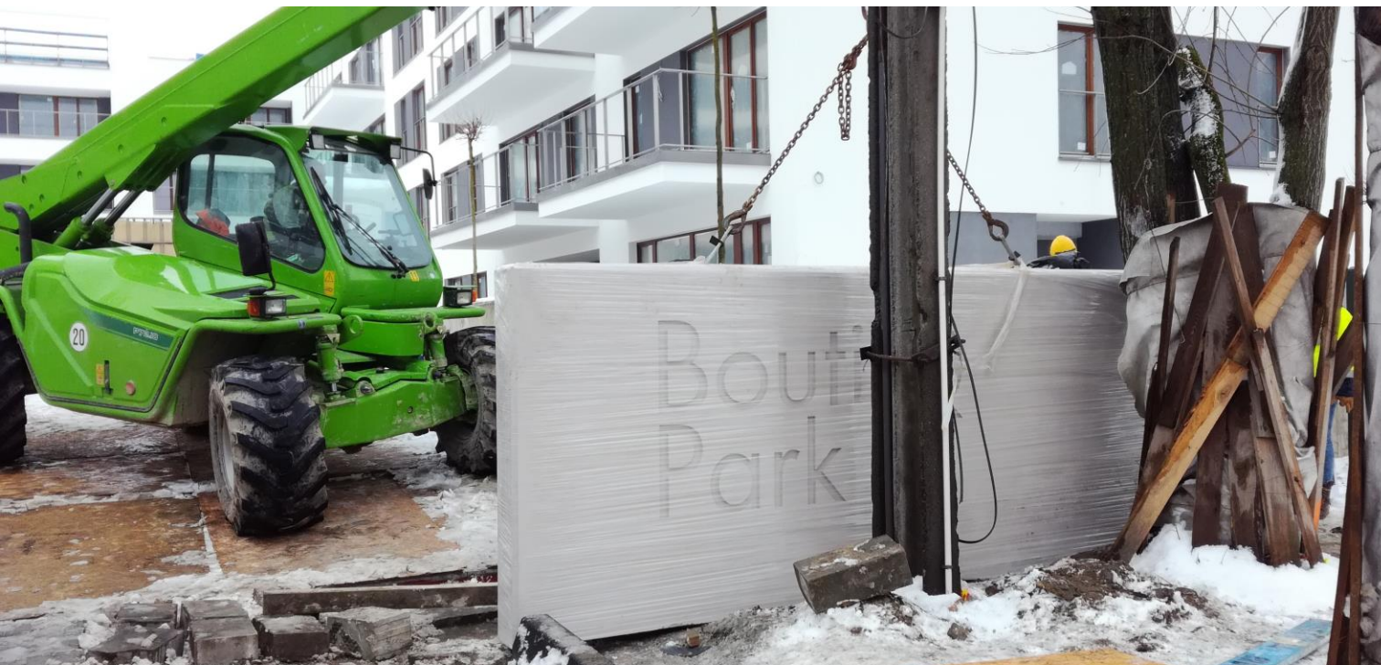
PREFABRYKATY Z BIAŁEGO BETONU MUREK Z TŁOCZONYM LOGIEM OSIEDLA W WARSZAWIE – DONICA Z TŁOCZONYM LOGIEM KOMPLEKSU BIUROWCÓW ALCHEMIA W TRÓJMIĘSCIE
