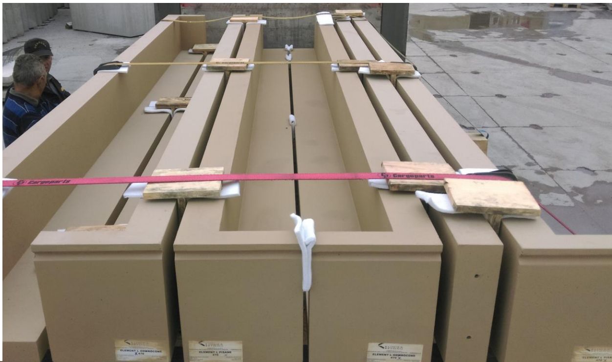
BUDYNEK BIUROWY W BŁONIU – ŻYŁKI I PLYTY OKŁADZINOWE 30mm W KOLORZE BEŻOWYM, BARWIONE W MASIE
